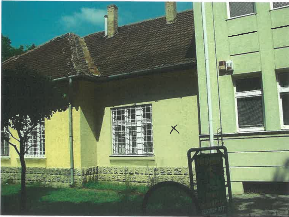
1. számú kép: utcai homlokzat részlet
